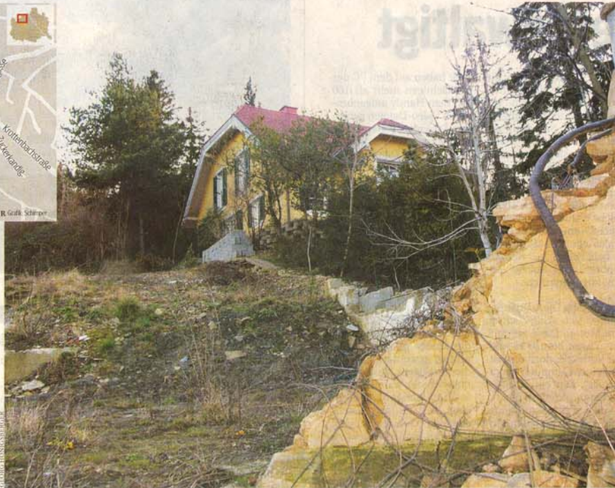
Ganz legal: Eine zehn Meter hohe Feuermauer, die begrünt werden soll, wird an der Grundstücksgrenze gebaut
